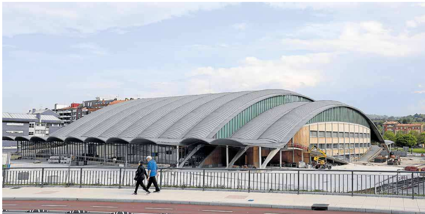
Las obras del Palacio de los Deportes, en la recta final después de dos años y más de 24 millones de euros de inversión. ALEX PIÑA
