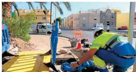
Imagen de archivo de obras en la red de abasto en Ingenio. CANARIAS7
